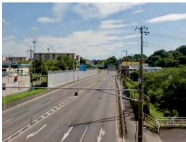
国道51号の遮音壁
