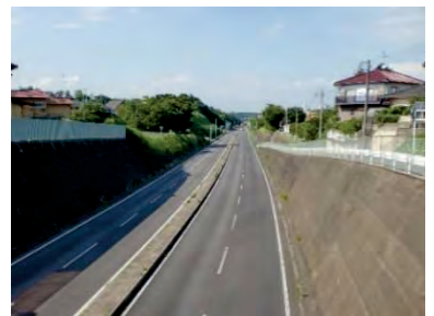
国道51号 掘割の巨大な擁壁
