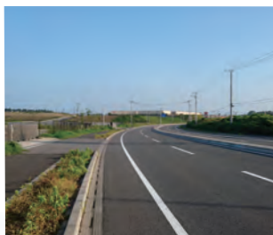
緑に囲まれたゆとりある2車線道路
