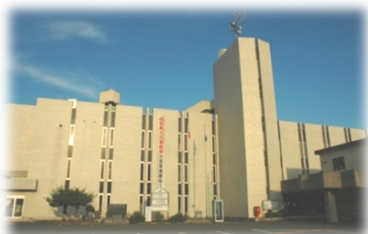
昭和47年建設 役場本庁舎
