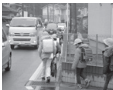
県道整備後(路肩部をカラー化)
