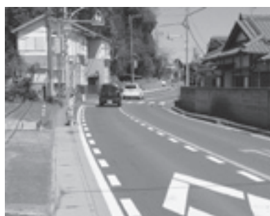
県道整備後(路肩部をカラー化)
