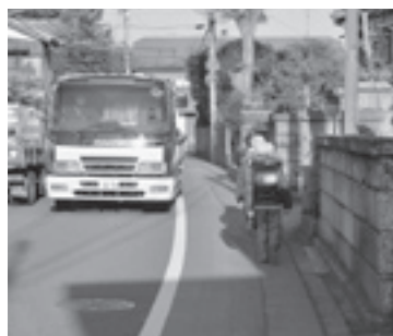
路肩拡幅後(路肩部をカラー化)
