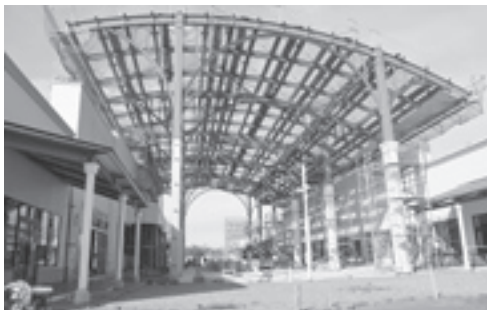
工事中のアウトレットモール
