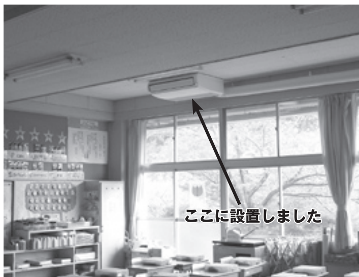
施工が完了した室内機（大室台小学校）
