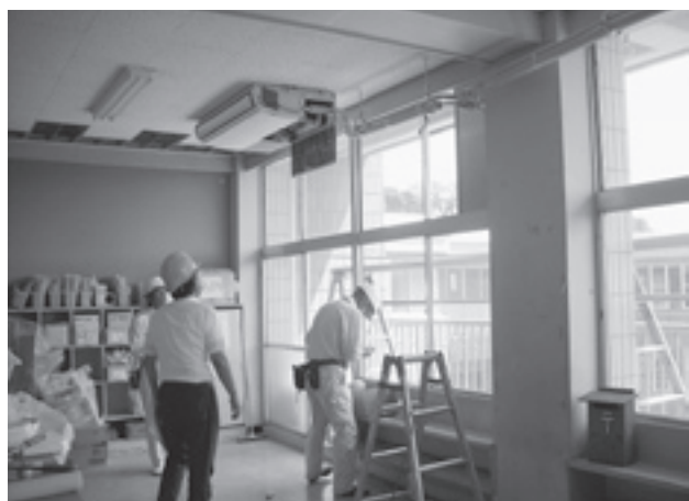
施工中の室内機（酒々井小学校）
