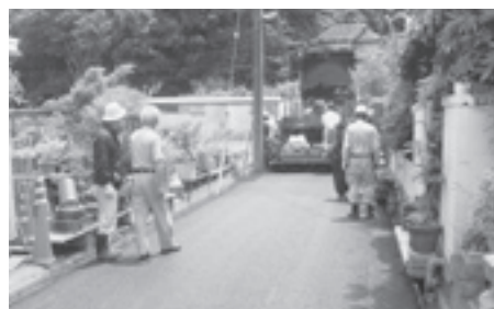
道路脇排水の整備と住宅地域の舗装整備をする地域住民の皆さん
