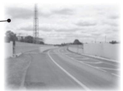
ICアクセス道路(県施工区間)
