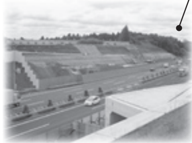
酒々井IC工事
