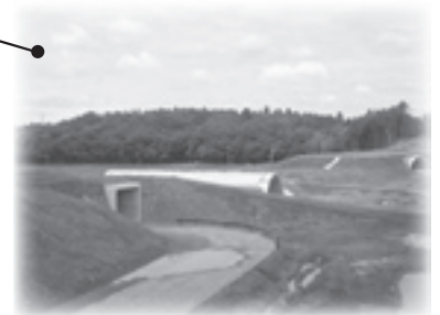
ICアクセス道路(町施工区間)
