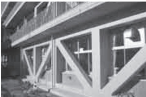
耐震化された酒々井小学校北校舎
