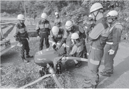
中継ポンプを操作している様子
