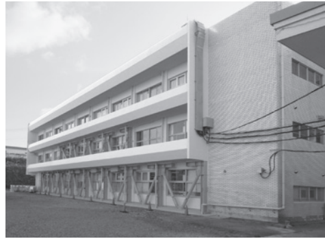
中央庁舎耐震工事（ブレース外観）
