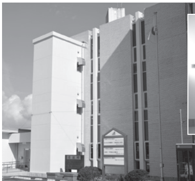
新設されたエレベーター（外観）
