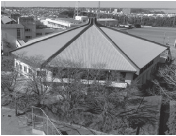
改修された酒々井中学校体育館の屋根
