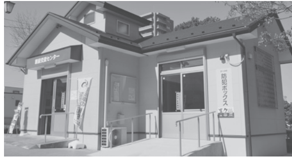
駅前交流センターに増設した防犯ボックス
