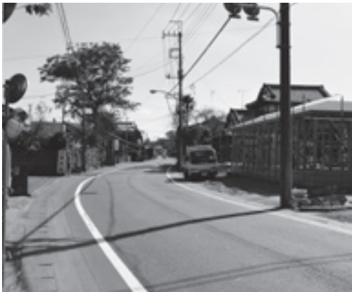
順次工事が進められる町道02-009号線
