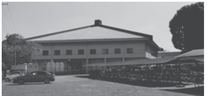
屋根の抜本的な改修工事が予定されている酒々井中学校体育館
