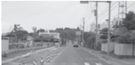
道路工事の様子
