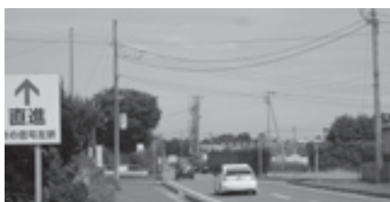
東関東自動車道をまたぐ古沢橋
