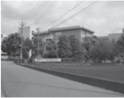
小中学校に太陽光発電を設置 (写真は酒々井中学校)
