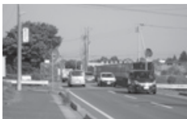
東関東自動車道に架かる古沢橋
