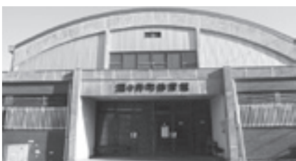
昭和41年に建設された町体育館 現在は安全面から休館中
