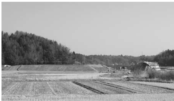
ICアクセス道路整備工事
