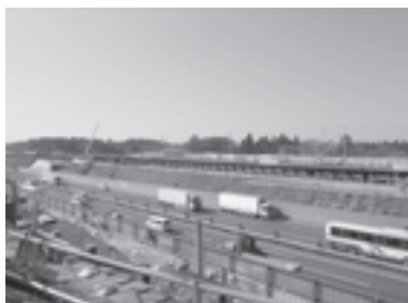
平成25年開設に向けて 工事中の酒々井IC
