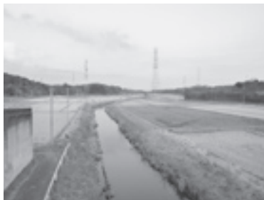
新堤橋(県道成東酒々井線)から見た高崎川
