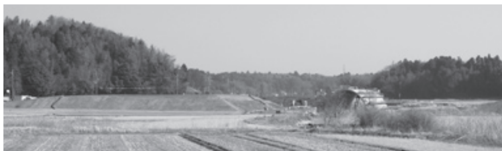
I Cアクセス道路整備工事
