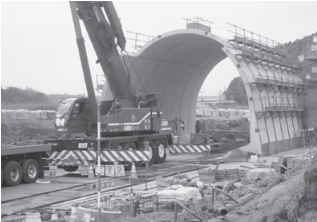
ICアクセス道路整備工事
