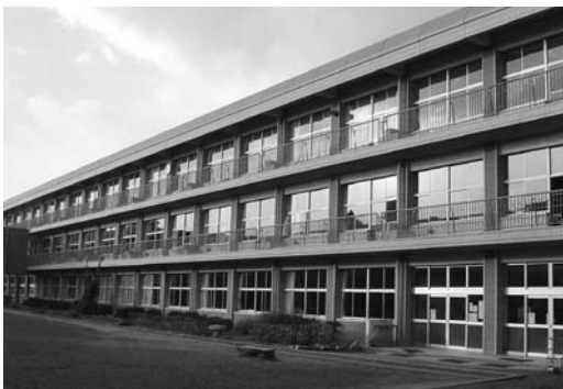
町内小中学校の耐震補強工事と大規模改造工事が行われます。 ※写真は酒々井小学校北校舎
