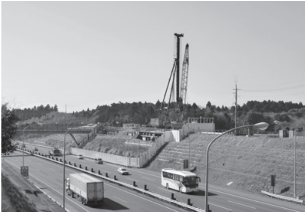
千葉県施工のインターチェンジ本体工事
