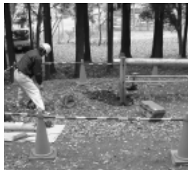
総合公園の遊具修繕
