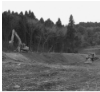
(仮称)酒々井インターチェンジ 予定地における工事
