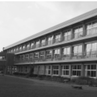
平成22年度に補強工事を実施する酒々井小学校北校舎
