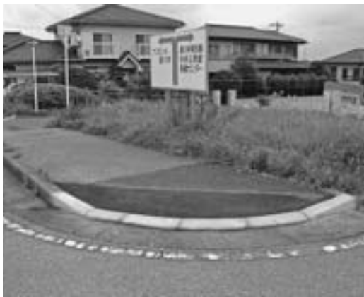
段差解消の切り下げ工事が行われた歩道（中央台）
