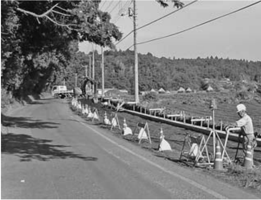
伊篠新田地区に通じる町道の拡幅工事(上岩橋地先)
