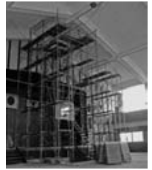
大室台小学校体育館天上囲い込み工事
