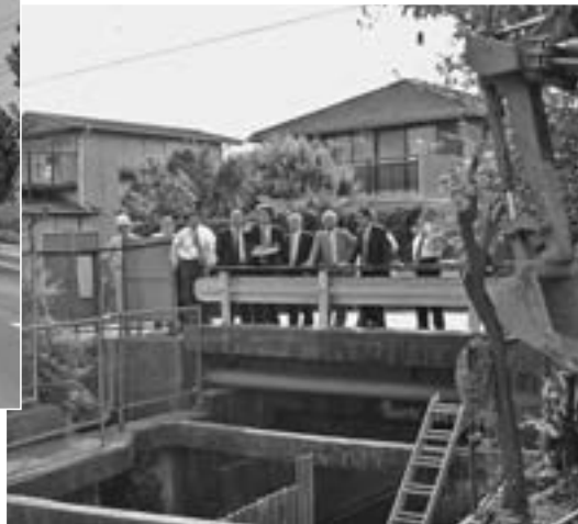
現在改修工事を実施している中川排水路
