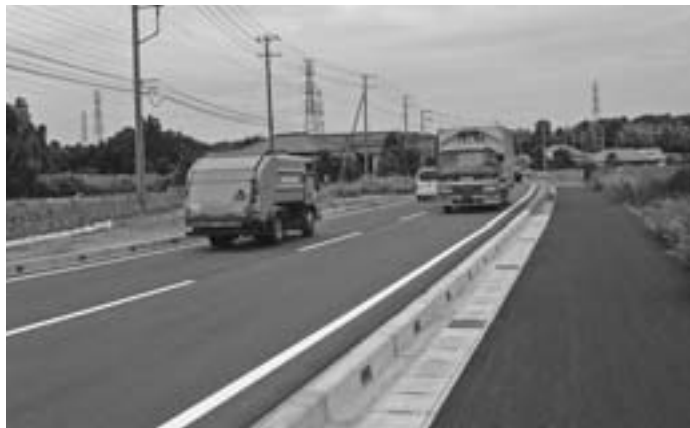
大型貨物車やごみ収集車が多く通過する県道富里酒々井線（写真は拡幅改良が完了した部分）
