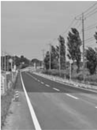
改修工事が終了した町道01-005号線
