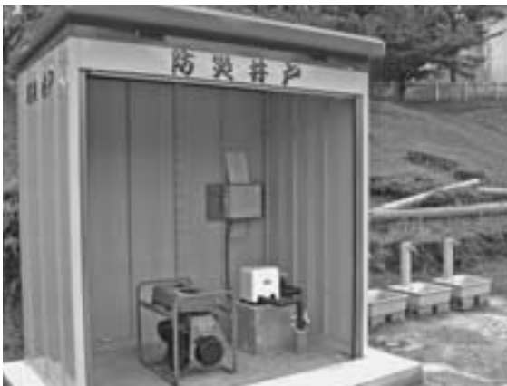
平成16年度に大室台小学校校庭に設置された防災井戸
