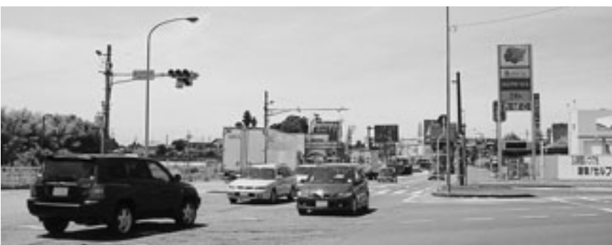
改良工事が行われる国道51号線 =酒々井交差点付近=
