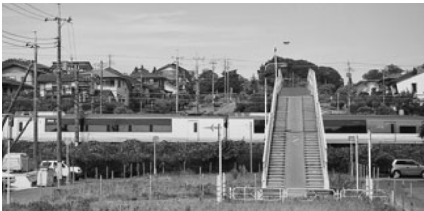
JR成田線によって分断されている市街地 = 跨線橋は都市計画道路の一部として計画認定されている =
