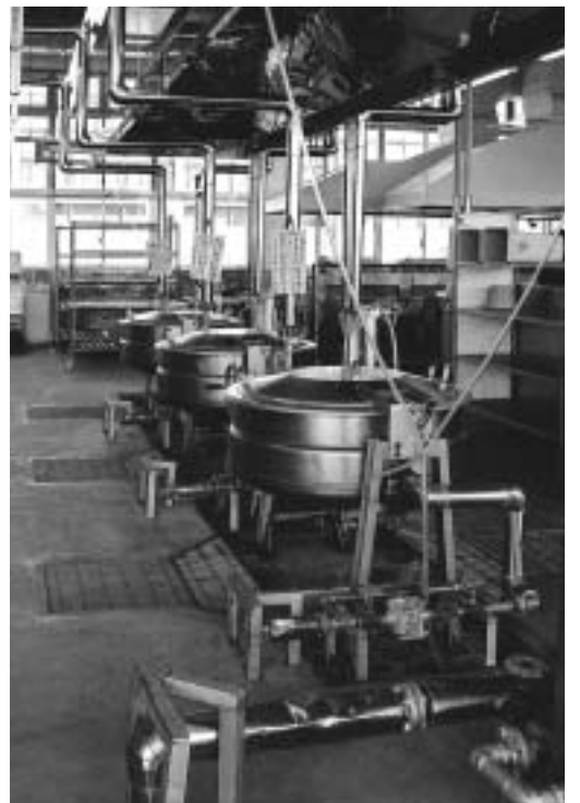
改修工事が行われた給食センター調理室
