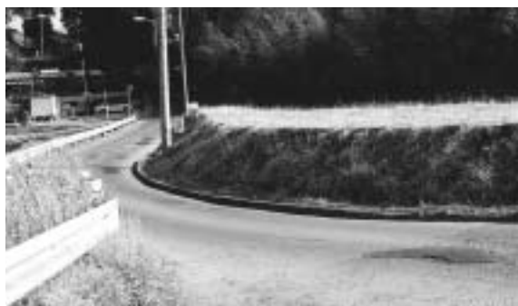
地盤安定の工事を行う伊篠新田地先の町道
