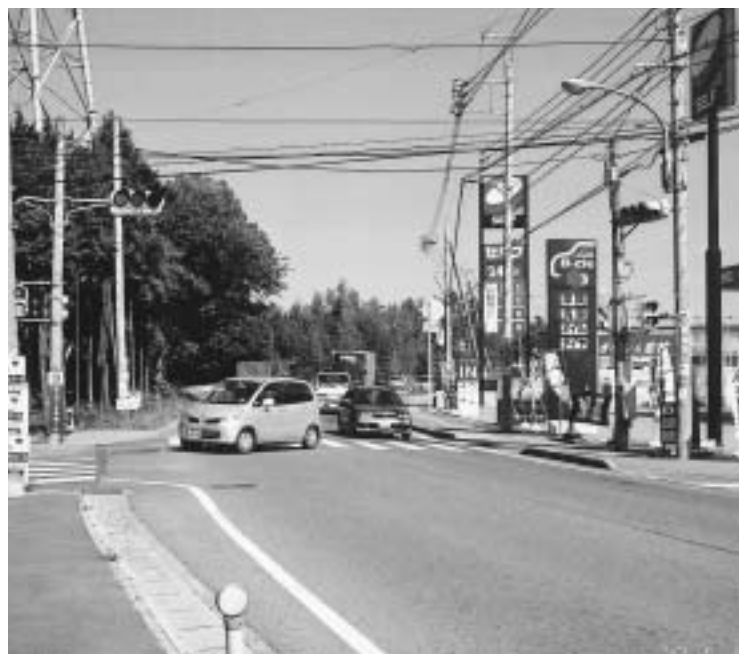
改善が待たれる国道296号東酒々井入口交差点
