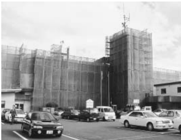
防水工事を施工中の役場庁舎
