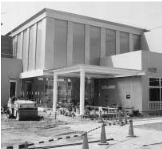
9月中旬の開館を目指して工事が進むプレミアム酒々井
