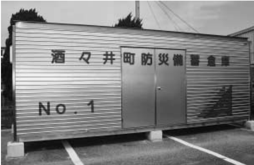
役場敷地内に整備された防災備蓄倉庫
