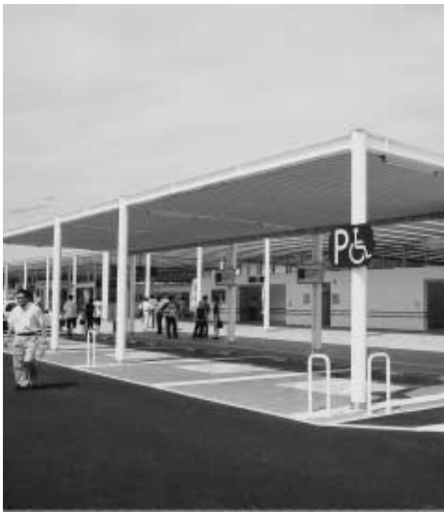
屋根付きの身障者専用駐車場等バリアフリー対策が強化された酒々井PA下り線
