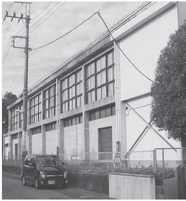
現在使用を中止している町民体育館
