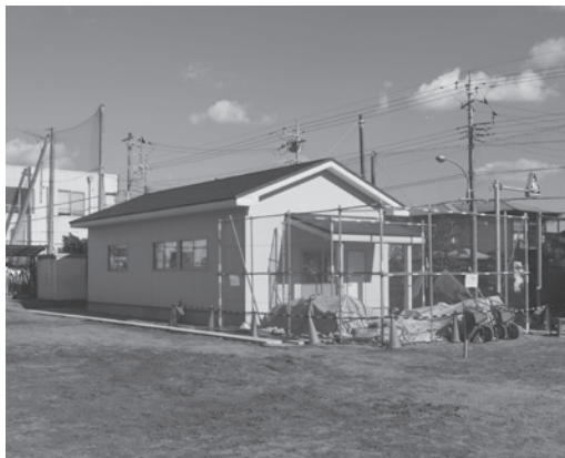
建設が中断している中央台の青少年交流施設
