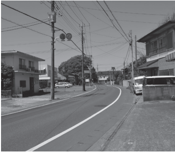
無電柱化が進められている酒々井町の町道
