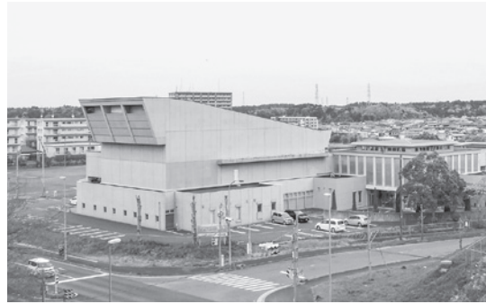
プリミエールの増築は令和2年3月完成予定
