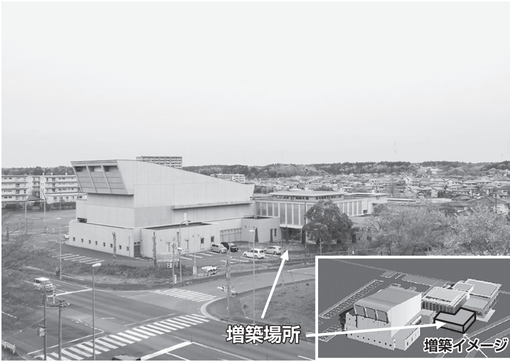
増築工事の完成は令和2年3月を予定しています
