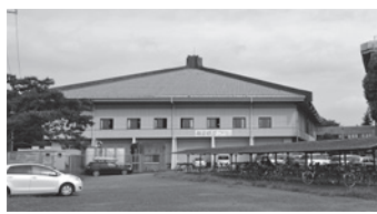
屋根の改修要望がある体育館
