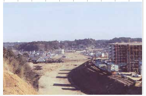
工事中の国道51号バイパス(昭和55年)
