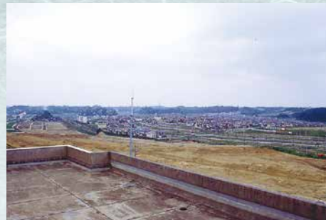
役場屋上から見た、造成中の中央台団地(昭和50年頃)
