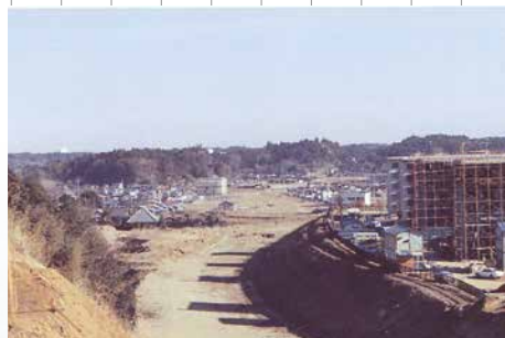
工事中の国道51号バイパス(昭和55年)
