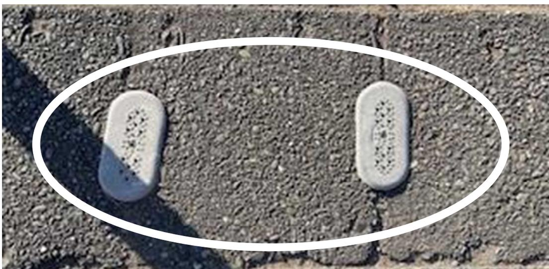
ゴムの蓋を設置した。ただし、継ぎ目が大きいところが多いため、段階的に設置していく。
