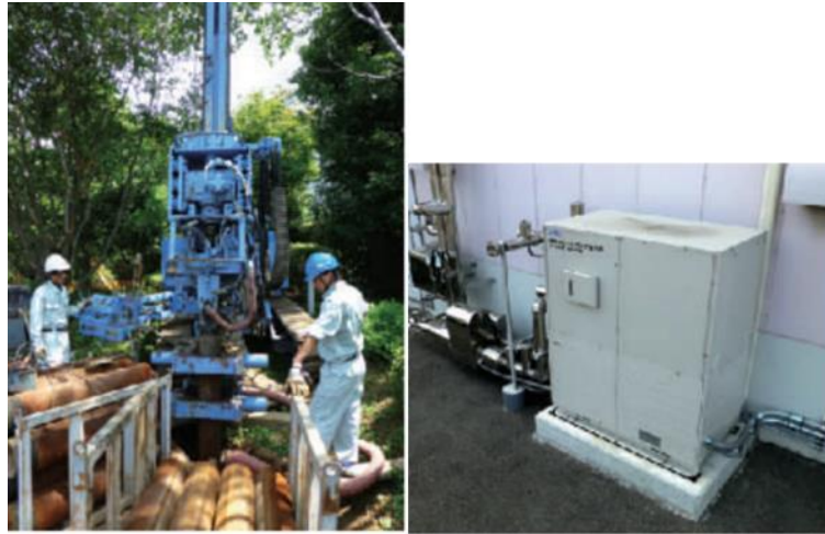
図 3-10. 地中熱利用空調機の建設時の様子と室外機の外観 24
