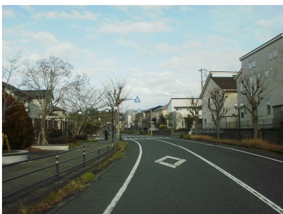
図 3-2 酒々井町における無電柱化の状況
