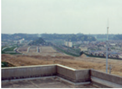
造成中の中央台団地
