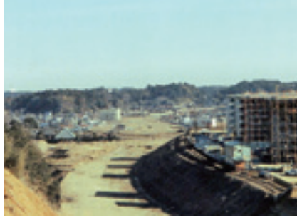
工事中の国道51号バイパス
