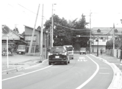
無電柱化を進めている 町道02-009号線 (酒々井区)
