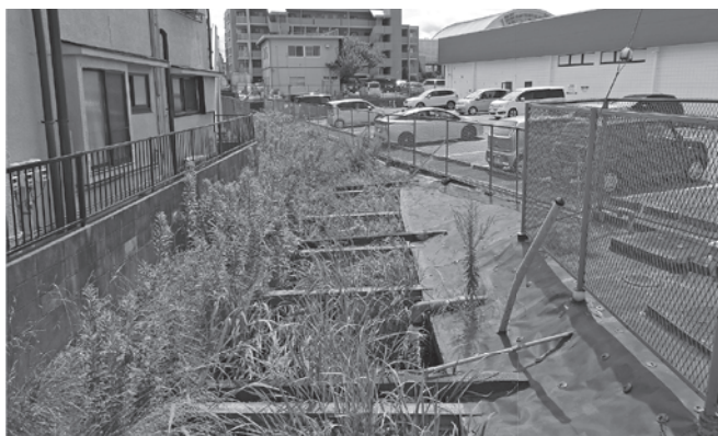
改築工事が予定されている 中川2号幹線(くすりの福太郎隣)
