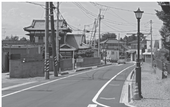
不適切な事務処理により返還金が 生じることとなった 町道02-009号線の無電柱化等工事
