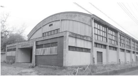
老朽化により使用を禁止している町体育館
