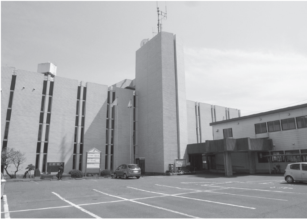
役場中央庁舎は耐震補強やアスベスト除去工事などを4月から約1年の工期で実施予定です
