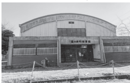
倉庫として利用されている町体育館
