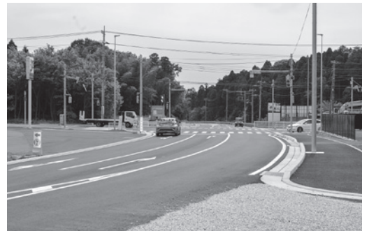
改良工事が行われたアウトレットに向かう交差点
