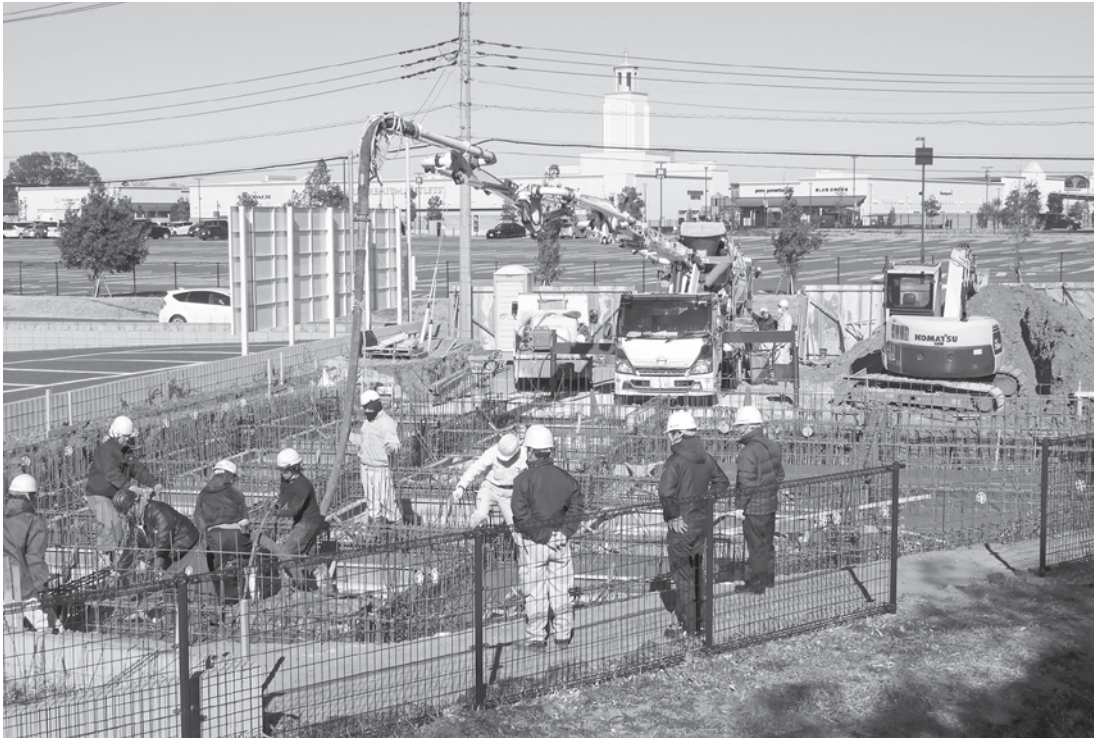
アウトレットに近接した場所で建設が進められている拠点施設（1月21日撮影）
