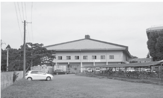
屋根改修工事が求められている中学校体育館
